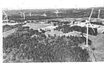
東急不動産などが共同出資する横浜町風力発電所
