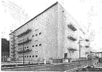
サンケイビル初の物流施設の外観
