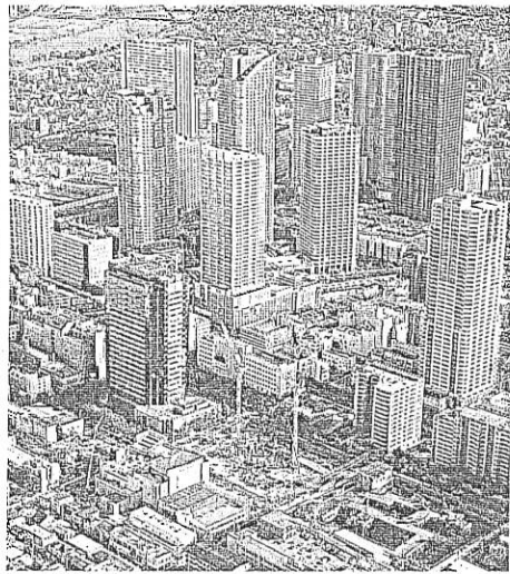
タワーマンション建設が相次ぐ武蔵小杉駅周辺。中央はタワーマンションの建設現場。川崎市中原区、本社へりから、堀英治撮影
